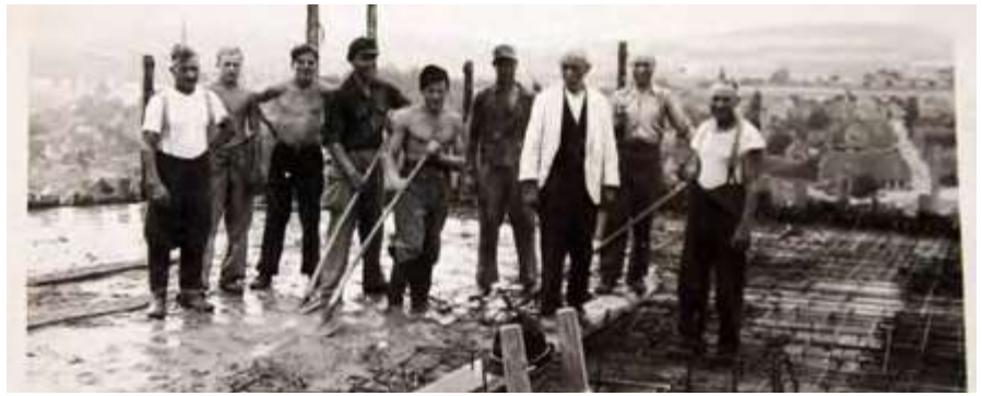
Zahlreiche historische Fotos wie hier von der Firma Rind & Söhne beim Bau des Hochbehälters am Kobersberg, bereicherten den Bericht von Josef Fischer zum Thema „Rümper un sei Meurer“.
