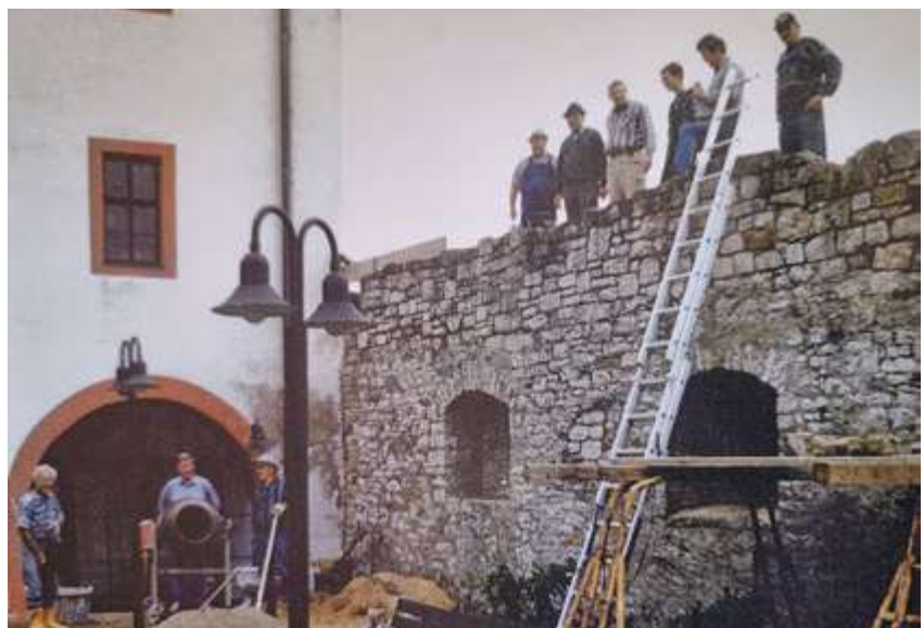
Mitglieder des Freundeskreises Schloss Grumbach mit dem 1. Bürgermeister Anton Kütt bei Sanierungsarbeiten am Schloss; Foto: Kurt Mintzel
